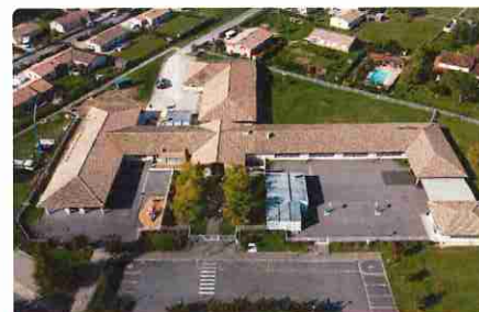
Projet de rénovation de l'école
